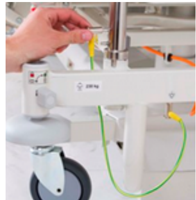
Figura 2. Cable de tierra
